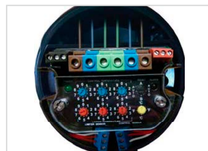
15. Установить модуль контроля ECM и завершить подключение проводов. Винты набора должны быть затянуты с усилием 1.4 Н*м. см. схему подключения. Установить температурные уставки контроллера и ограничителя на нужные значения.
